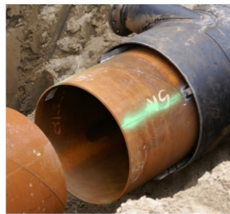
Doppelmantelrohrwärmetauscher
