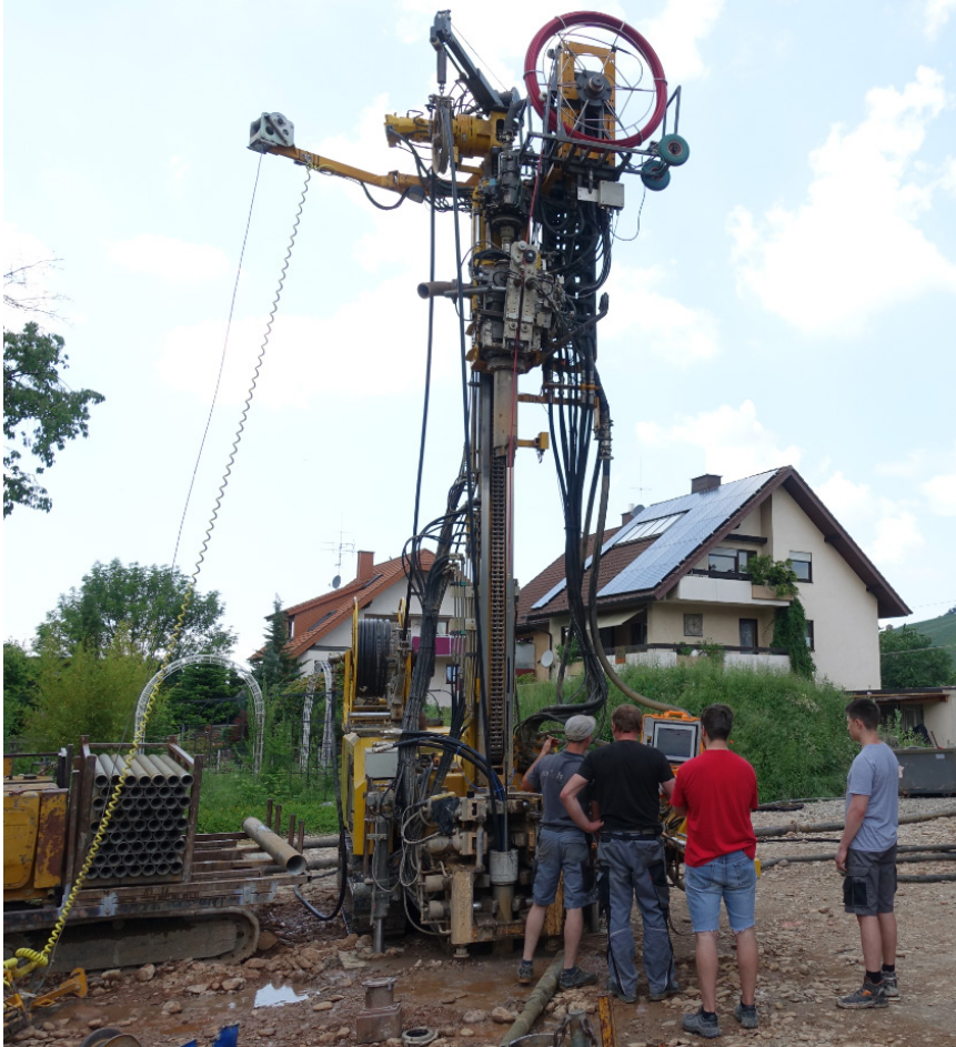
Erdwärmesondenbohrung
